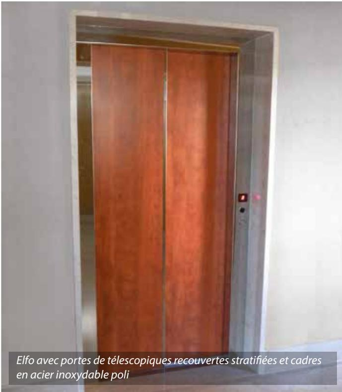
*Elfo avec portes de télescopiques recouvertes stratifiées et cadres en acier inoxydable poli*
