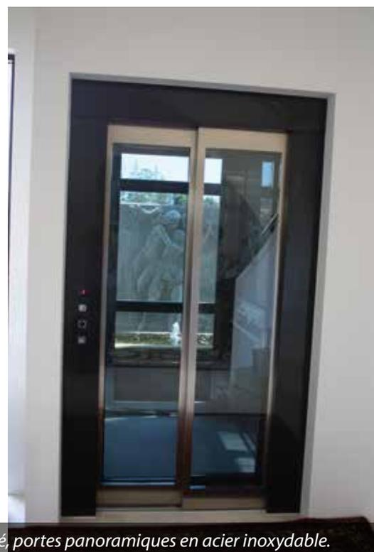
Gaine en structure métallique spéciale avec remplissage en verre à l'extérieur fumé, portes panoramiques en acier inoxydable.
